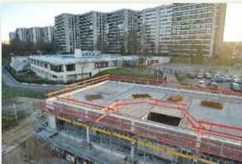
Le chantier de l'école Vlamincq à Grigny II.
