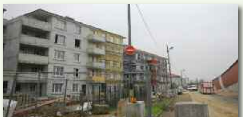
Le bâtiment qui accueillera des logements locatifs, des commerces et une maison médicale pluridisciplinaire en centre ville.
