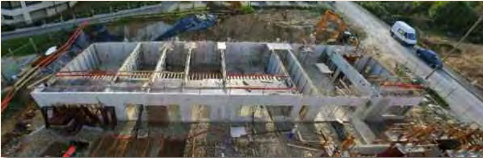
Vue panoramique du chantier du groupe scolaire Vlamincq (Galadriel).
