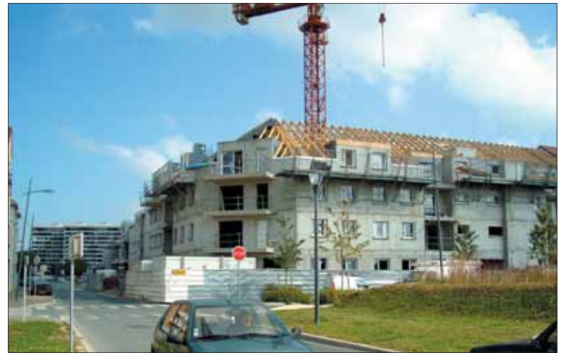
Le nouveau centre-ville ; ici, le programme de logements en accession à la propriété.
