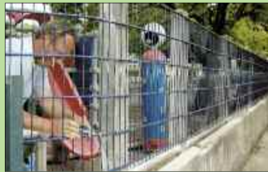
Pose d'une nouvelle clôture au Chat Botté.
