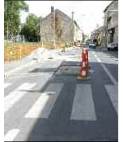
Intervention sur les canalisations rue Pierre-Brossolette.
