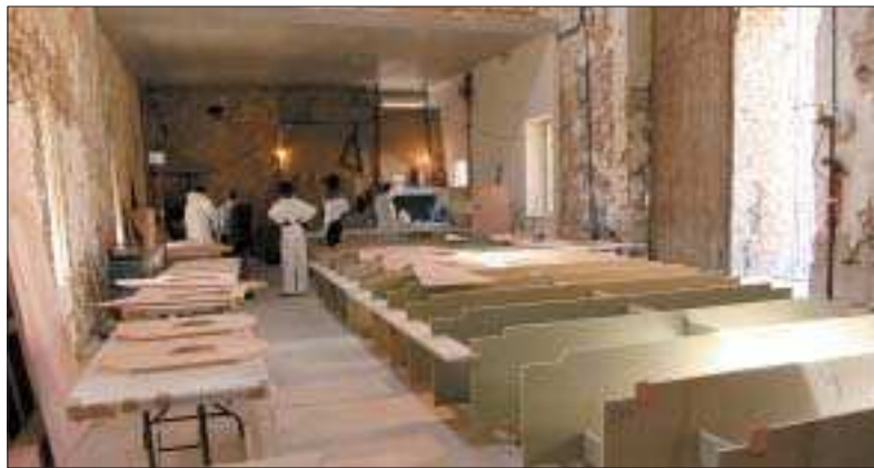
Le chantier, dans une grange de la Ferme Neuve.
