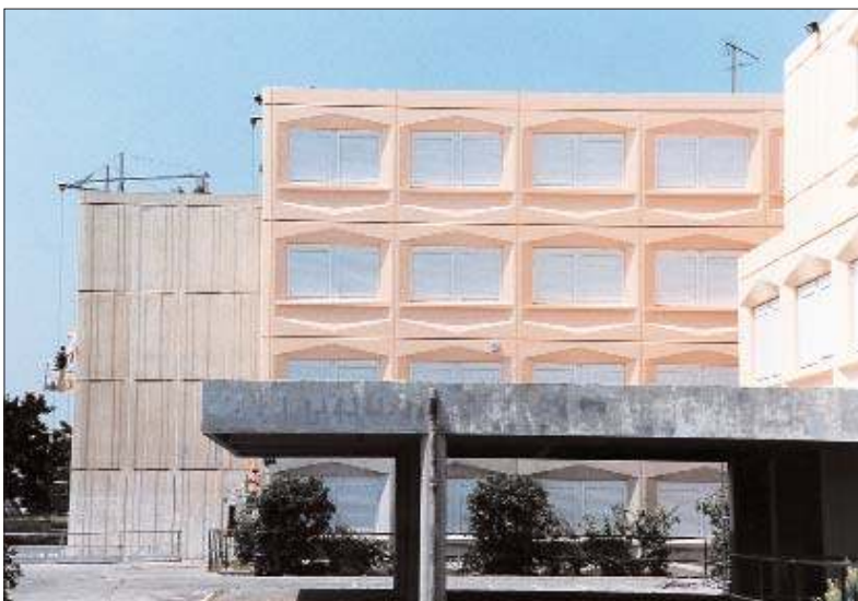
Le collège Pablo-Neruda en cours de rénovation par le Conseil général.
