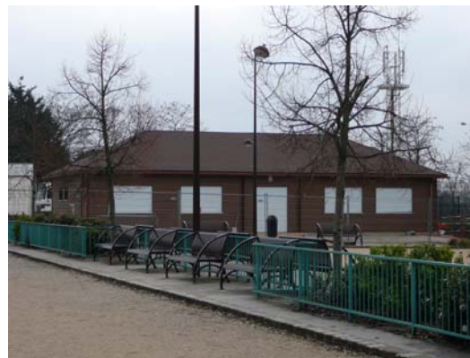
Local pour les boulistes situé Avenue de Flandres en cours de livraison
